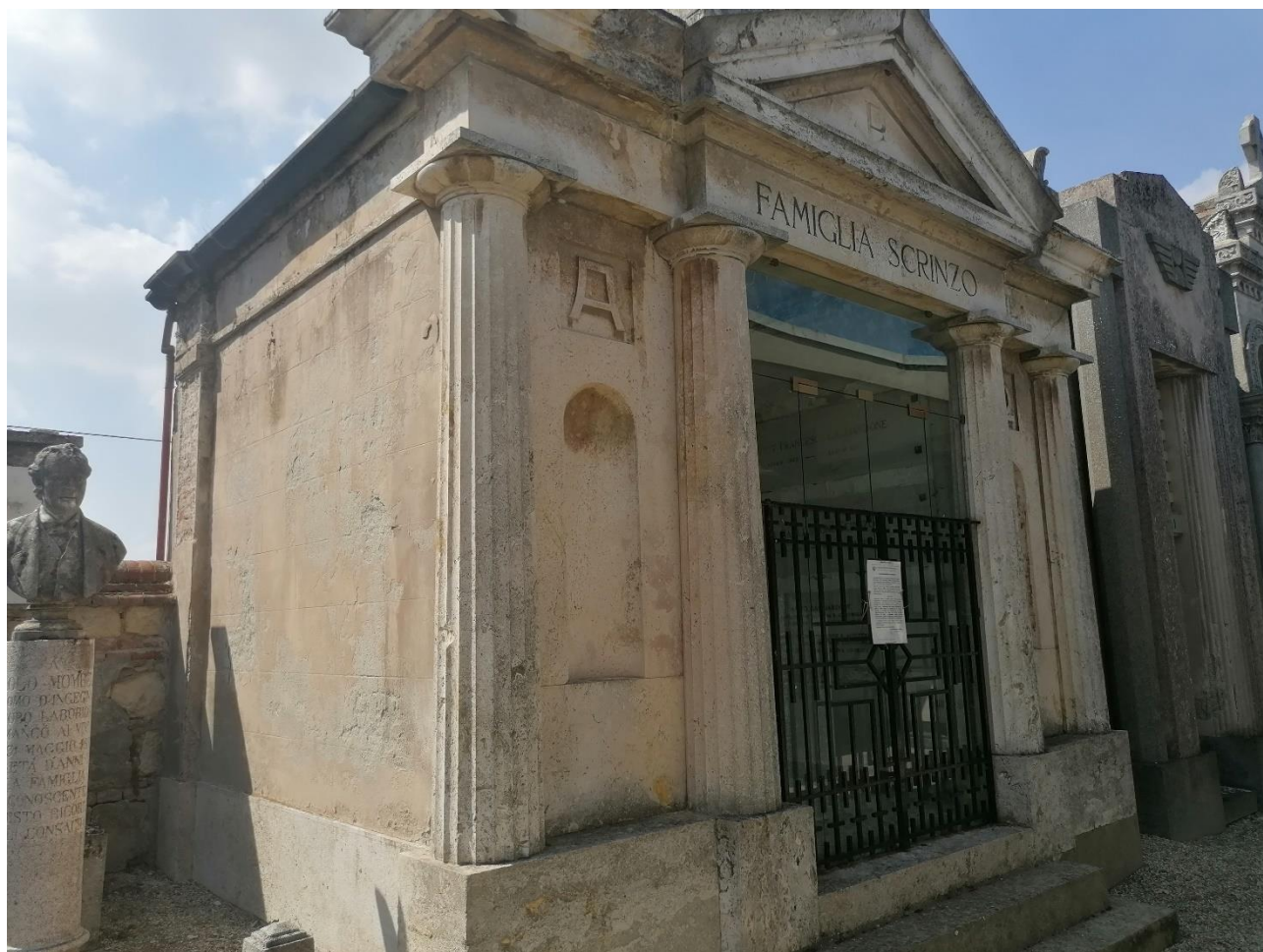
rilievo fotografico del 05.09.2022
